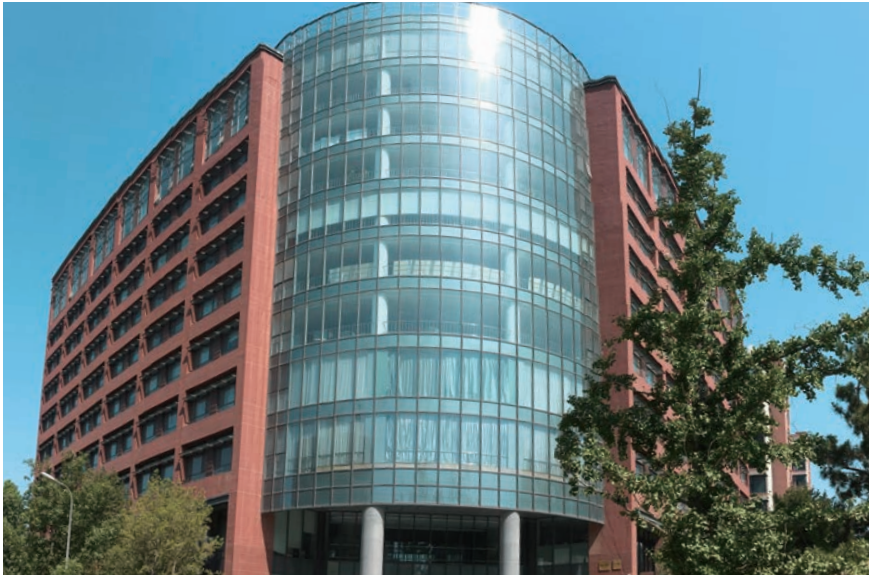
清华-罗姆电子工程馆外观
