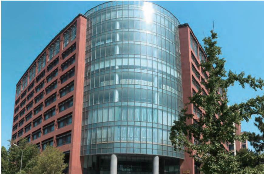
清华 - 罗姆电子工程馆外观
